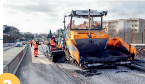
**2** L'enrobé est déversé dans des engins spécifiques appelés finisseurs<sup>(2)</sup>. Il s'agit d'une machine constituée à l'avant d'un immense réservoir et à l'arrière d'une table d'application. Le matériau chaud (180 °C) va passer dans un système de vis sans fin qui le dirige vers la table pour répartir cette couche de manière uniforme sur toute la largeur de la machine.
