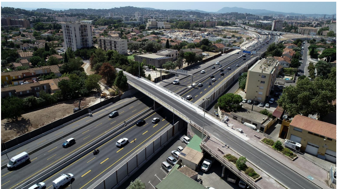
A57 – Secteur du pont de la Coupiane © Elite Drone – Août 2024
