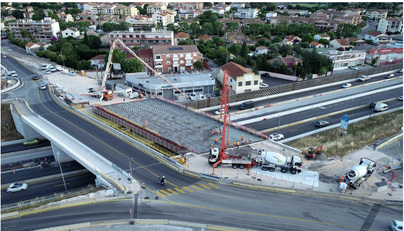
Élargissement A57 – Bétonnage du pont des Fourches © Elite Drone – Mai 2024
