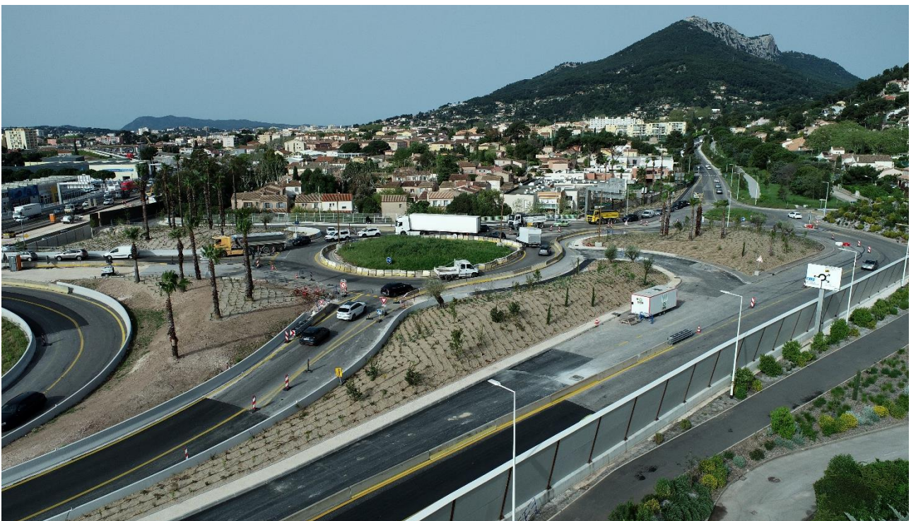
Élargissement A57 – Secteur de la Bigue © Elite Drone – Avril 2024
