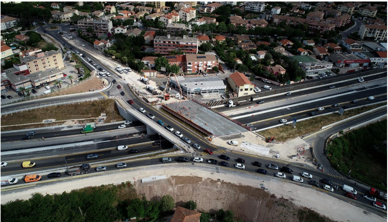
Élargissement A57 – Secteur des Fourches © Elite Drone - Mai 2024
