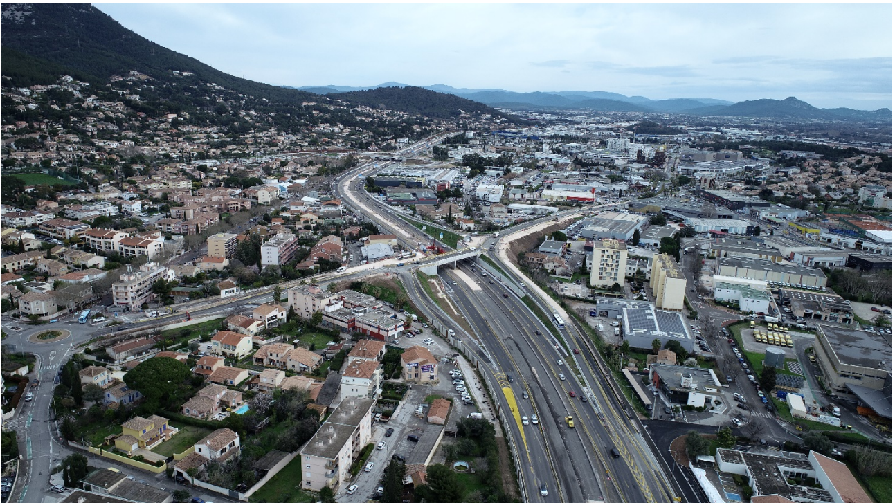
Elargissement A57 – Secteur les Fourches © Elite drone - Février 2024
