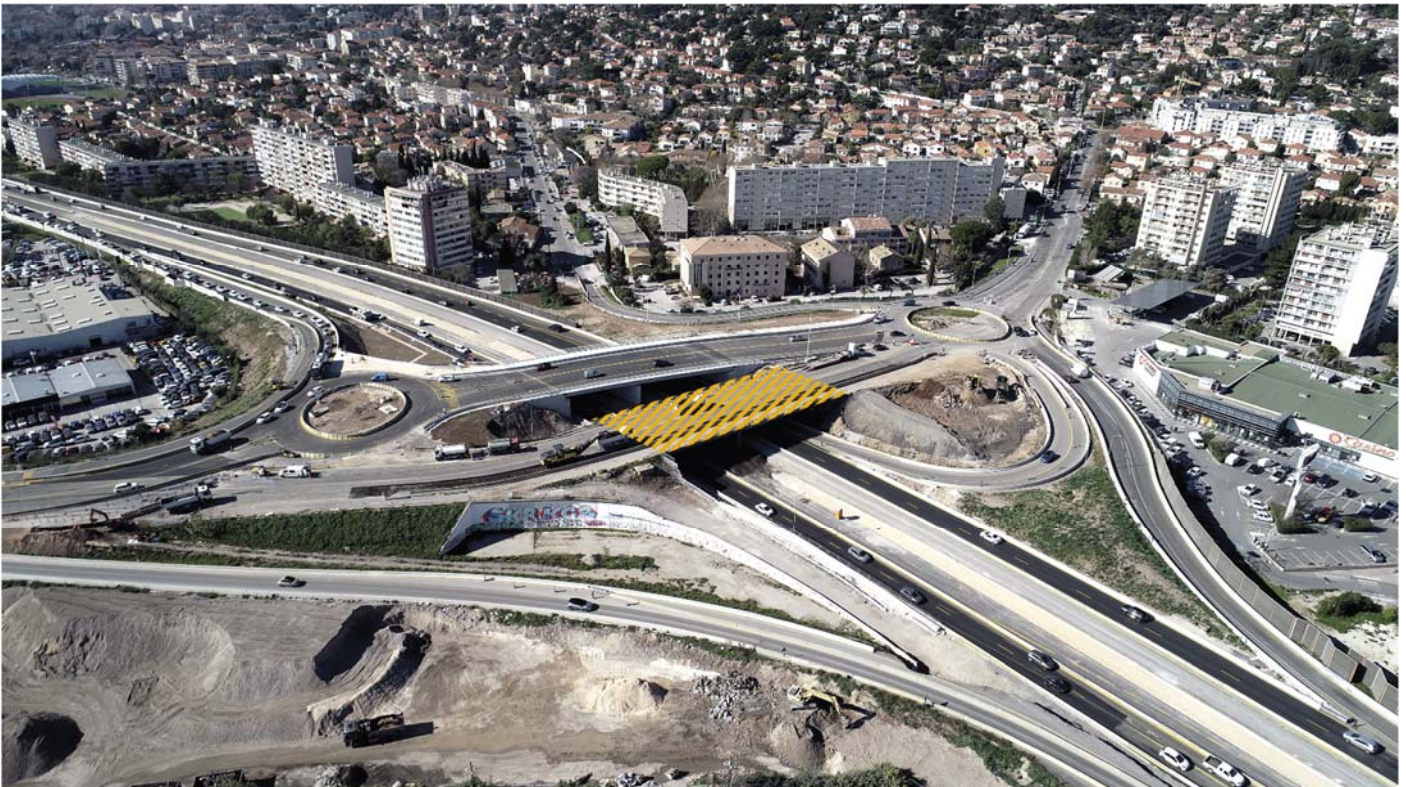
L'ancien pont, matérialisé en orange, sera détruit par moyens mécaniques. (Crédit photo Elite Drone)
