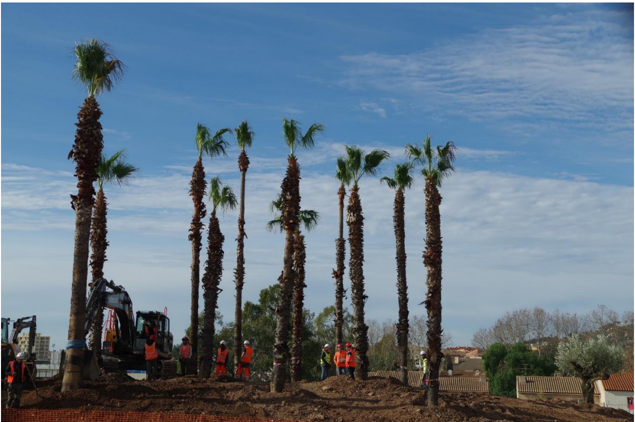
Elargissement A57 – Plantation des palmiers qui avaient été retirés au début des travaux puis entretenus par la pépinière Guyomar (Hyères) en attendant leur retour aux abords de l'A57. © VINCI Autoroutes - Mars 2024
