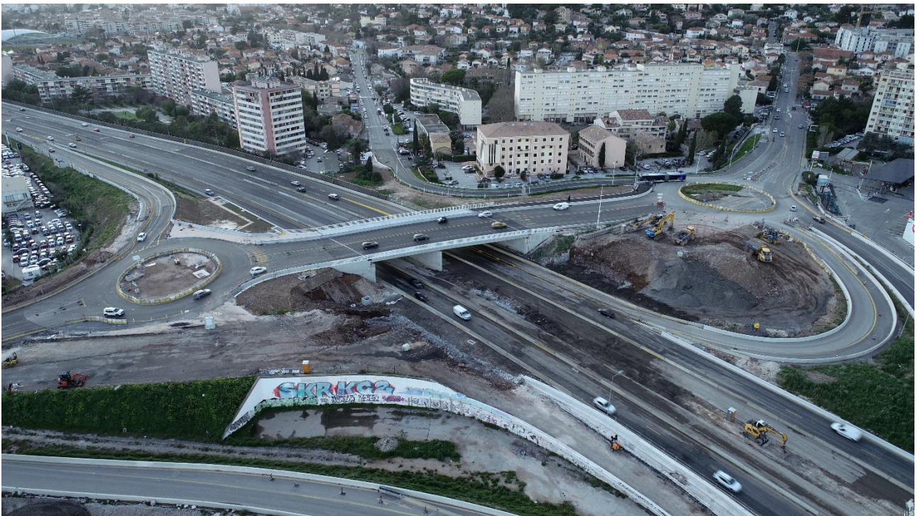
Élargissement A57 - Réouverture de l'A57 à la circulation après l'opération « coup de poing » qui a permis aux équipes de démolir l'ancien pont de l'échangeur de La Valette Centre (n°3). - Photo Elite Drone - Mars 2024
