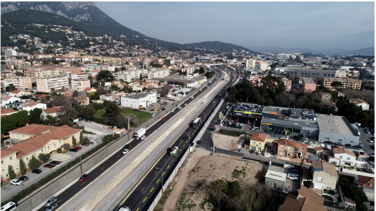
Élargissement A57 - Février 2024 - Création de la 3 e voie dans le terre-plein central de l'autoroute / Secteur de la Coupiane Photo Elite Drone
