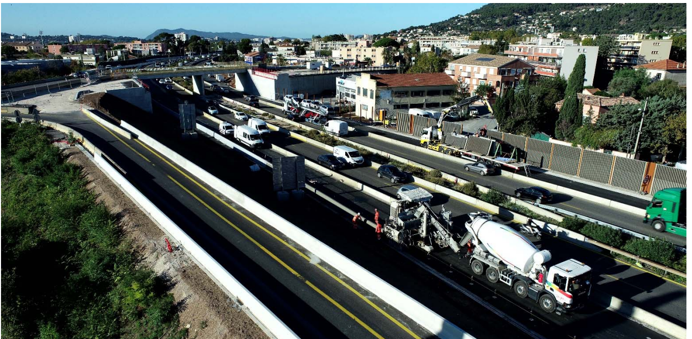
Elargissement dans le secteur La Valette Sud et pose d'écrans acoustiques : Photo Elite Drone
