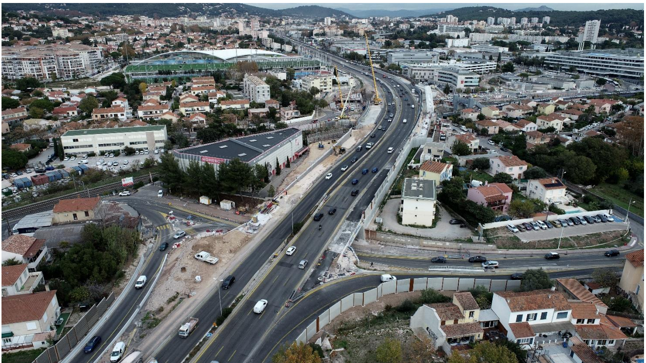
Élargissement A57 dans les secteurs de La Palasse et de Sainte-Musse : Photo Elite Drone
