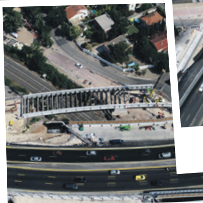
Déconstruction du pont provisoire Été 2023
