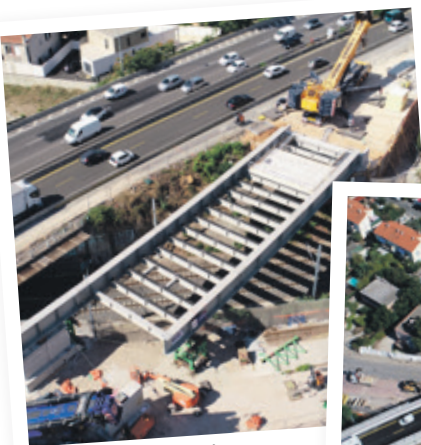
Création du pont provisoire Été 2021
