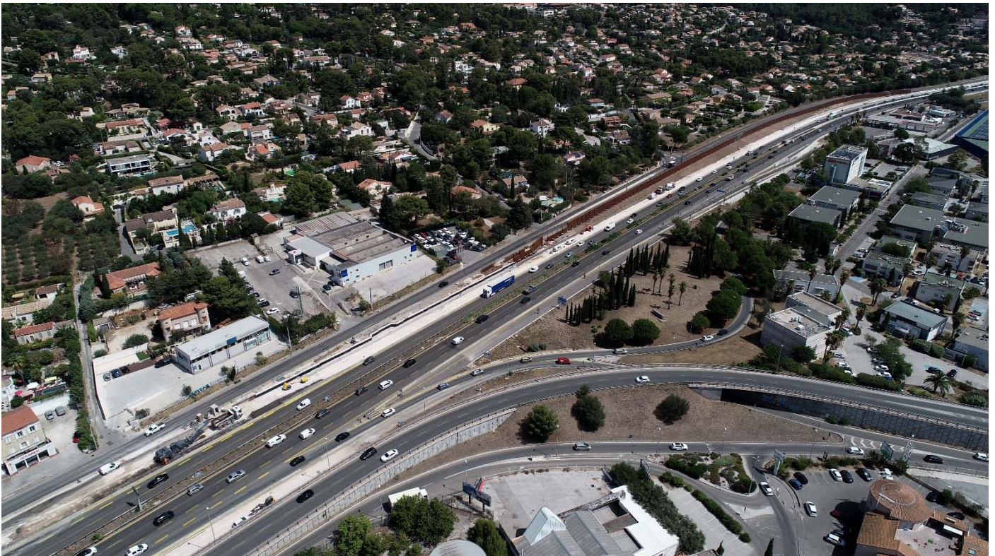
Le secteur de la sortie Valgora (n°5c) est très contraint entre l'autoroute A57 et l'entrecroisement des autres bretelles d'accès (Crédit photo : Elite Drone)
