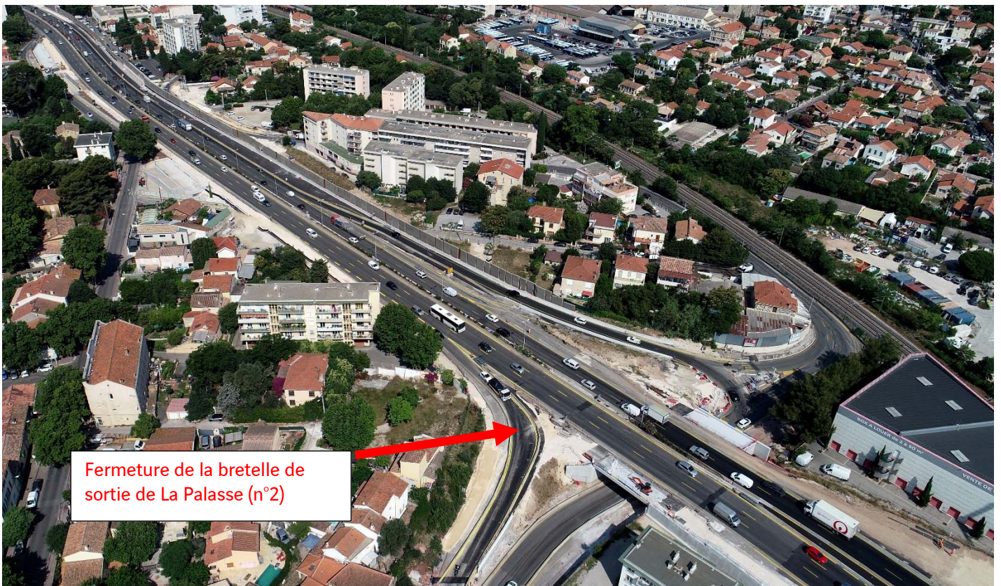
L'échangeur de La Palasse est situé dans un endroit extrêmement contraint entre l'autoroute, le réseau secondaire et les habitations. (Photo Elite Drone)
