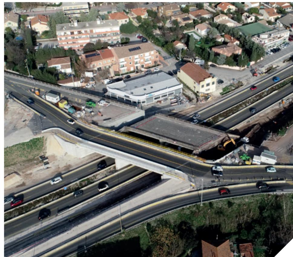
Dans le cadre du chantier d'élargissement de l'A57, l'échangeur de La Valette-du-Var Centre (n°3) appelé aussi l'échangeur des Fourches, a fait l'objet de travaux d'envergure avec la construction d'un nouveau pont finalisé en novembre dernier. Maintenant, une nouvelle étape se prépare pour déconstruire l'ancien pont de la Rue Eugène Blanc qui enjambe l'autoroute A57 dans le même secteur, durant le week-end des 11 et 12 février prochains\*.
